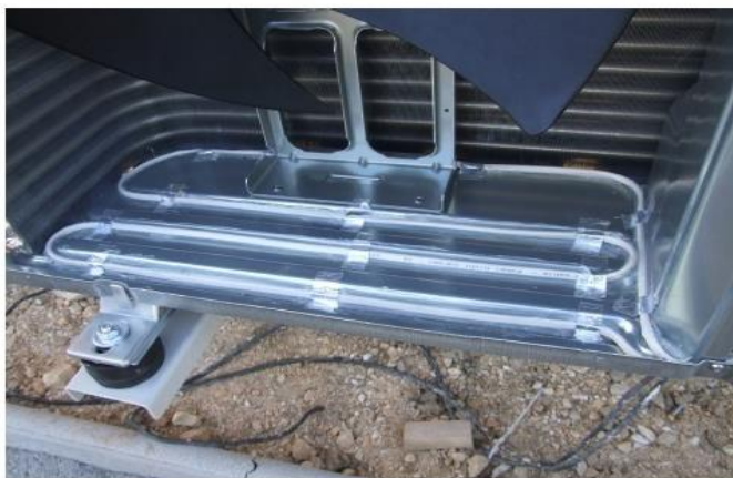
Inštalácia ohrevného káblu do vonkajšej jednotky
