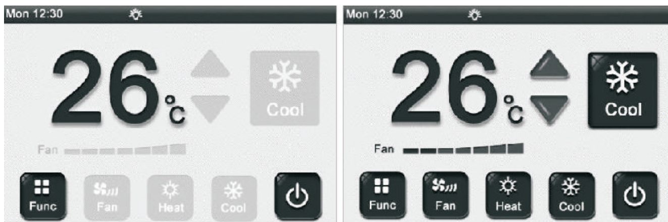
Príklad: Vypnutá klimatizačná jednotka
